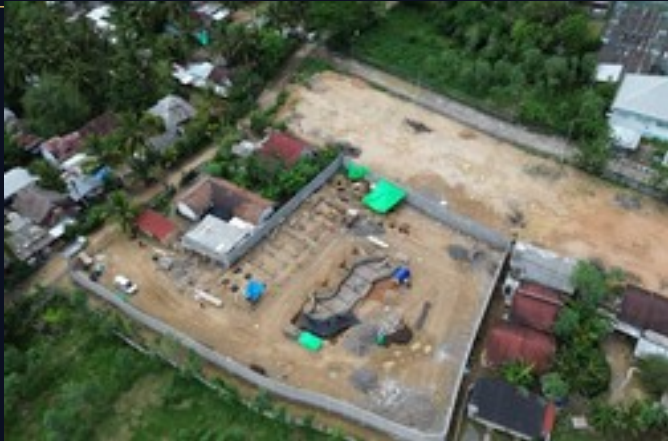
Construcción de piscina · hormigón y perfilado orgánico
