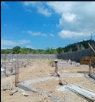
Cimentación · armado de pilares
