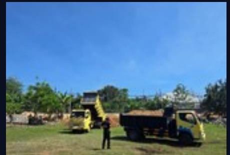
Aporte de tierra y nivelación de superficie
