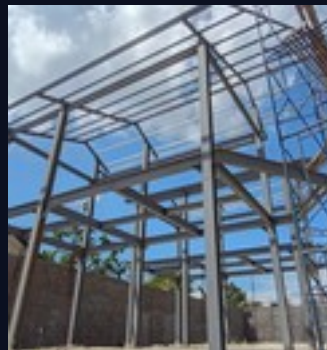
Elevación de estructura · dos plantas
