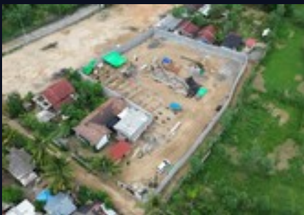
Vista aérea · inicio de cimentación
