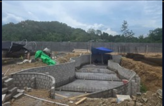
Vista aérea · progreso de cimentación
