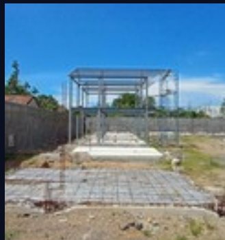
Estructura metálica · planta baja
