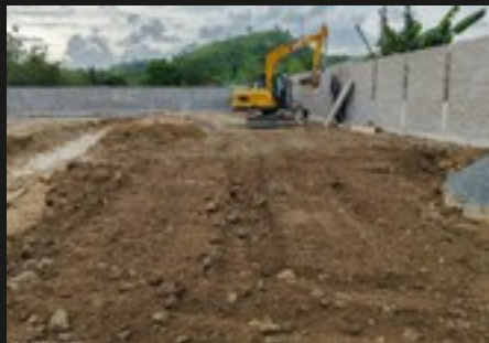
Site levelling · elevation progress
